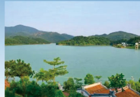
广东揭阳新亨镇供水工程
