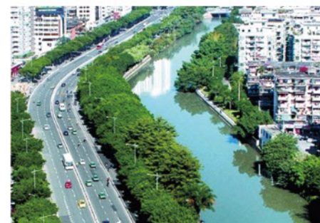
福州市内河改造提升工程
