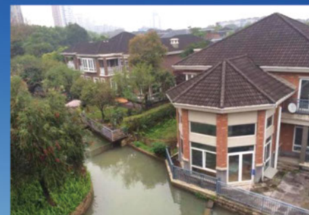
福州融侨桂湖温泉城给排水管道
