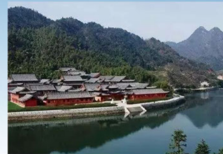
湖北黄梅县蔡山移民建镇给水工程
